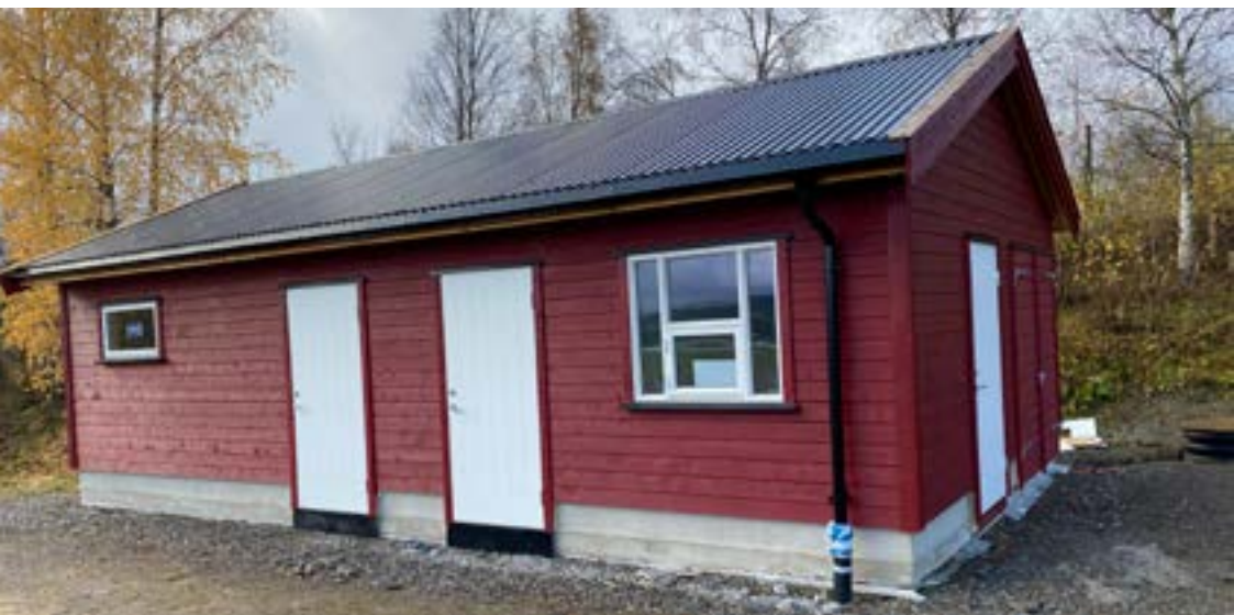
Den nye idrettsbua ved Røysing Stadion blir ferdig våren 2022.
